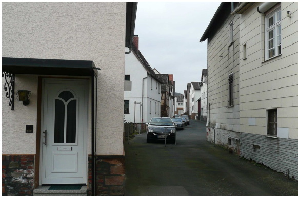
Beispiele für eine nicht ortsbildgerechte Verkleidung der Fassade und Gestaltung der Haustür
