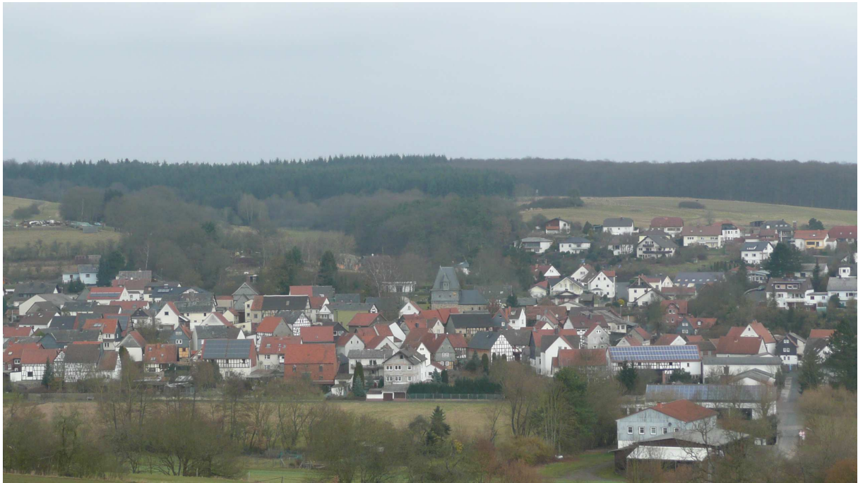
Blick auf die Dachlandschaft von Salzböden
