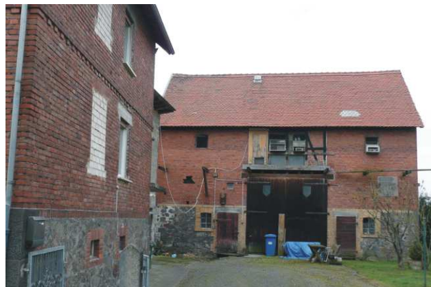
Gehöft in Backsteinbauweise
